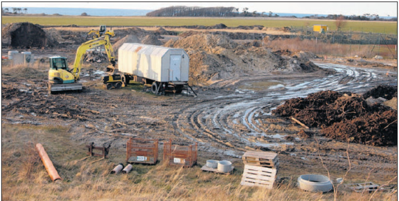
Im Wittower Ort Lancken laufen seit Oktober 2007 die Erschließungsarbeiten für den neuen „Wohnpark Meeresblick“.
